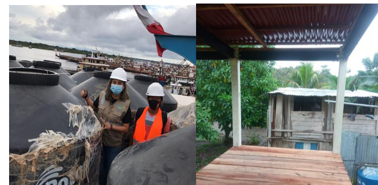
MÓDULOS DE AGUA DE LLUVIA EN EJECUCIÓN, CON NÚCLEOS EJECUTORES
