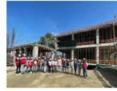
ESTABLECIMIENTO DE SALUD TACALÁ (2 visita a obra)
